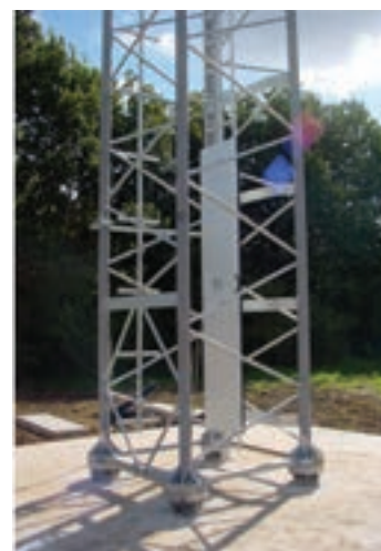
ALUMINIOWA OSŁONA ZABEZPIECZAJĄCA PRZED NIEPOŻĄDANYM WEJŚCIEM
